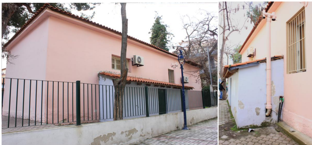
Απόψεις Κτιρίου Α Δημοτικού Σχολείου
