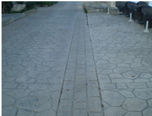
Εικόνα 3: σταμπωτό δάπεδο τοπικού δρόμου
