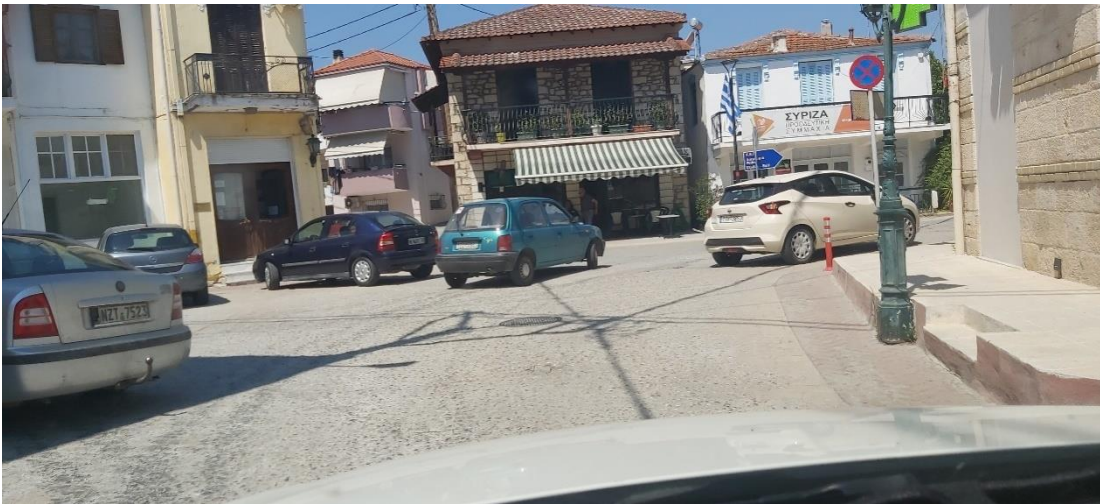
Ρηγματώσεις, λείανση επιφάνειας, απώλεια επιφανειακών υλικών ασφαλοτότητα.
