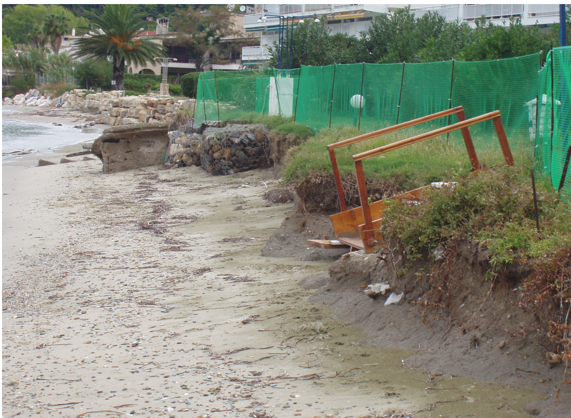
Φωτ. 5 Αυτοσχέδιες κατασκευές προστασίας (βόρειο τμήμα παραλίας Φούρκας)
